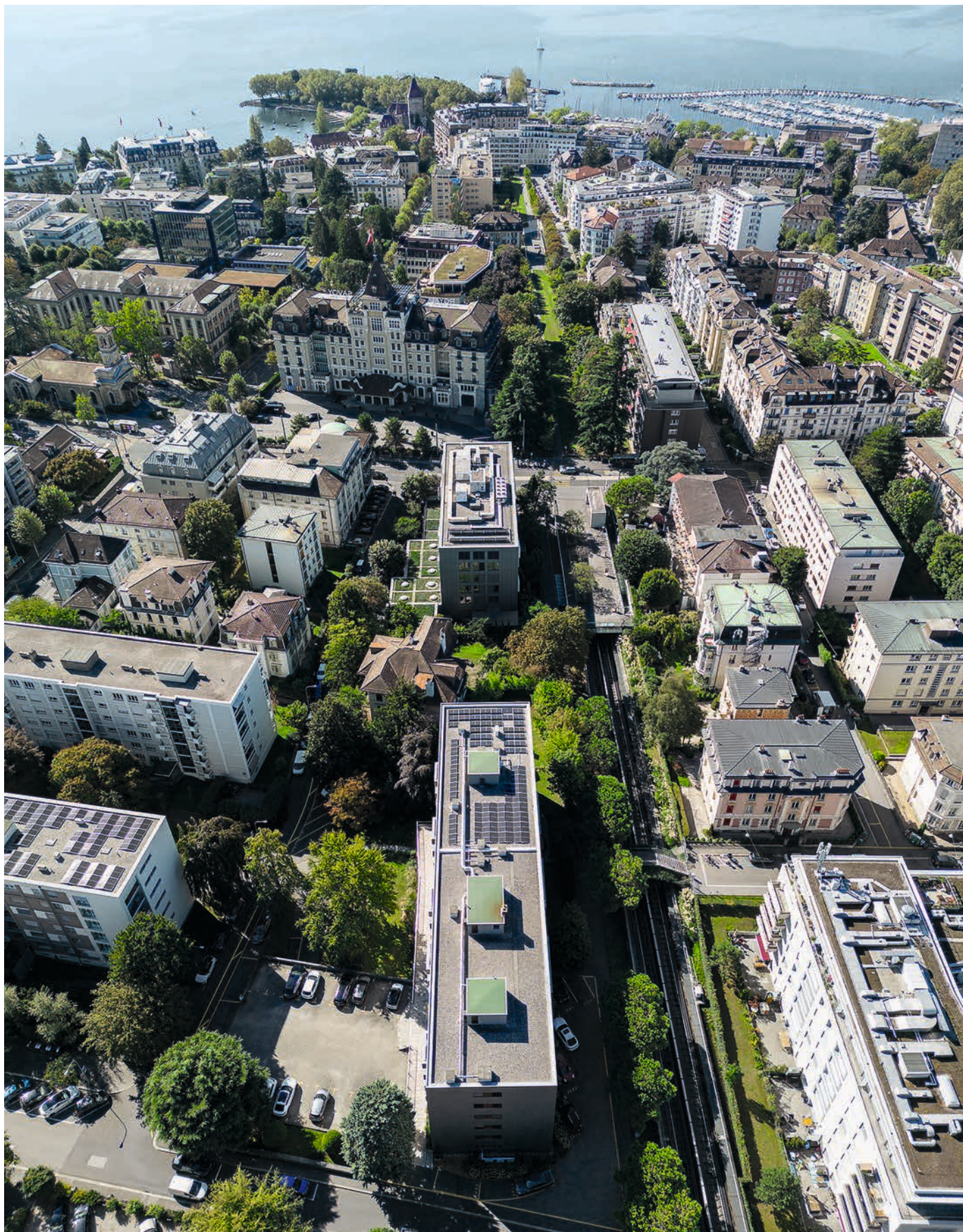
Das Bild zeigt in der Mitte das Gebäude am Chemin de la Joliette 2 in Lausanne mit der neuen Photovoltaikanlage auf dem Dach.
