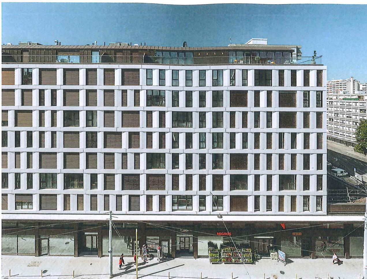
les parements clairs des façades sont une alternative moins intensive en carbone et plus durable que le béton traditionnel. Ils se caractérisent par leur légèreté, leur faible bilan carbone lors de la production et leur apparence élégante qui laisse les minéraux visibles.
