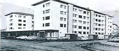
Rue St-Guérin 14-16-18, chemin du Vieux-Canal 35-37, Sion
