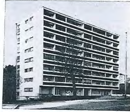
Avenue des Alpes 29 La Tour-de-Peilz
