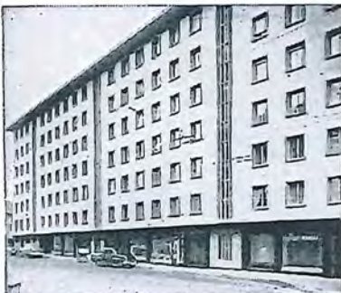
Rue de la Maladière 16, 18, 20 Neuchâtel
