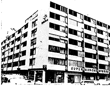
Rue des Pâquis 39-41, rue du Môle 2-4, Genève
