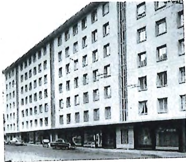
Rue de la Maladière 16-18-20 Neuchâtel
