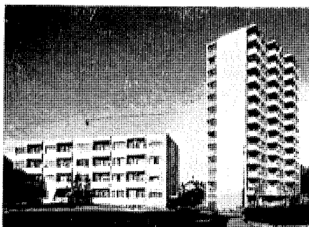
Rue de Vevey 49, rue du Tirage 2, rue des Ages 2, Bulle
