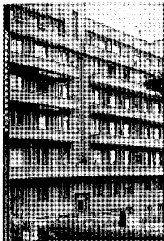
Chemin des Aubépines 5 Lausanne
