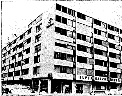
Rue des Pâquis 39-41, rue du Môle 2-4, Genève
