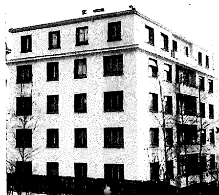
Rue de la Pontaise 21 Lausanne
