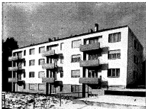
Boulevard de la Forêt 33-35 La Rosiaz, Pully
