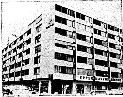
Rue des Pâquis 39-41, rue du Môle 2-4, Genève
