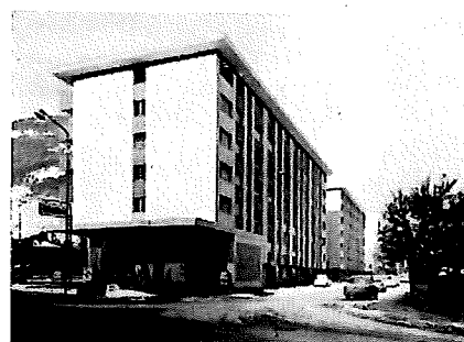
Avenue de la Moya 12-14 Martigny
