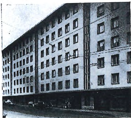
Rue de la Maladière 16-18-20 Neuchâtel
