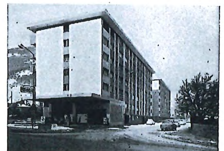
Avenue de la Moya 12-14 Martigny
