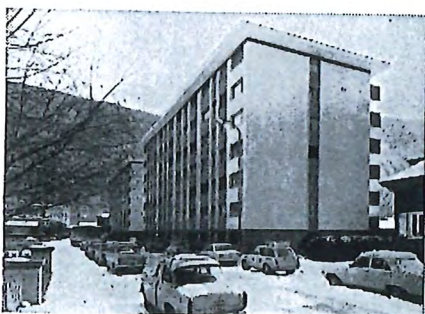
Avenue de la Moya 8-10 Martigny
