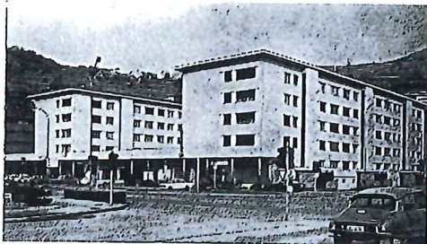
Rue St-Guérin 14-16-18, chemin du Vieux-Canal 35-37, Sion
