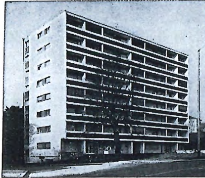
Avenue des Alpes 29 La Tour-de-Peilz
