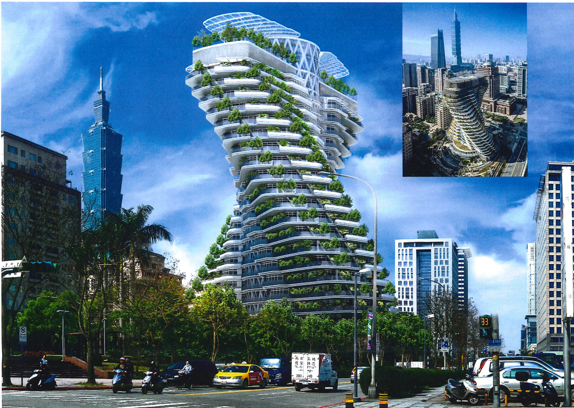
Projet et chantier (en petit) de la tour Tao Zhu Yin Yuan à Taipei (Taïwan) qui sera livrée fin 2018. Ses 25 000 plantes permettront d'absorber jusqu'à 135 tonnes de CO 2 par an.
